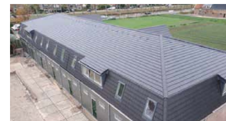
De verticale belijning gaat van de dakvoet via de knik in de mansardekap verder omhoog; van steil hellend naar flauw hellend (71° naar 19°).
