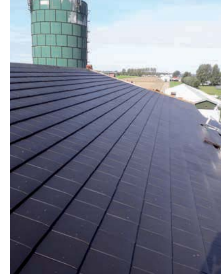
De kap is voorzien van dakpannen in een strak rechthoekig rasterpatroon. De mat antraciet stenen liggen niet in halfsteensverband, maar recht boven elkaar.
